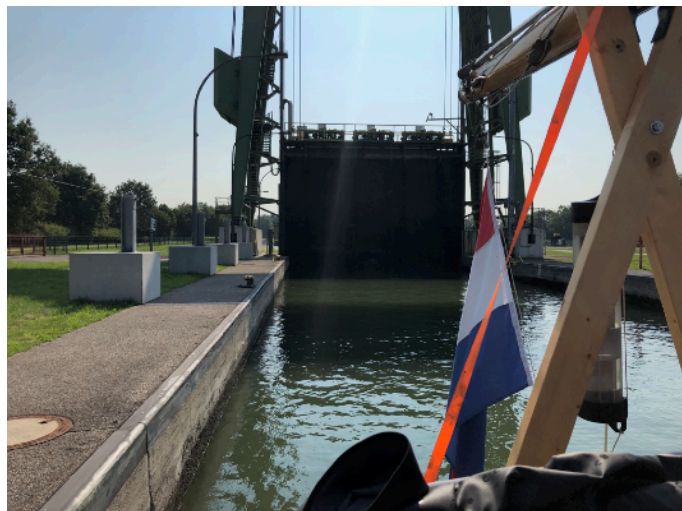
Sluis Datteln (Wesel-Datteln-Kanal)
