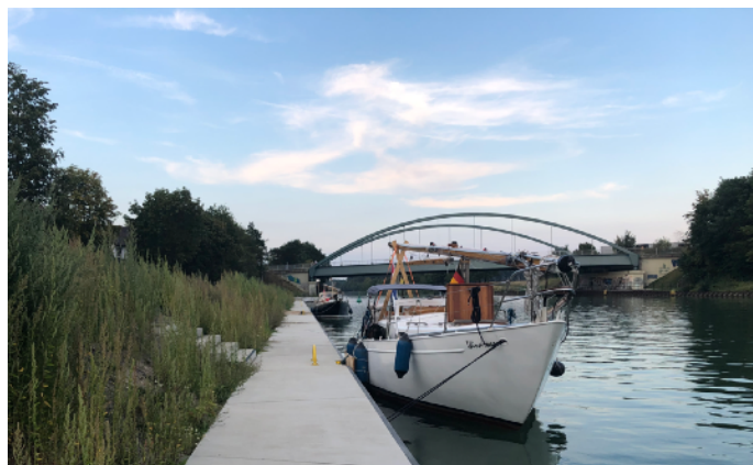
Kade in aanleg in Senden
